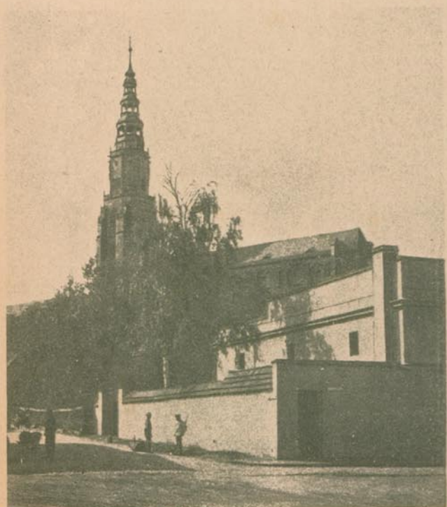
Außenansicht von der Bäckereistraße
