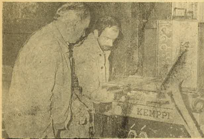
Elektrycy przy automacie spawalniczym KEMPI
